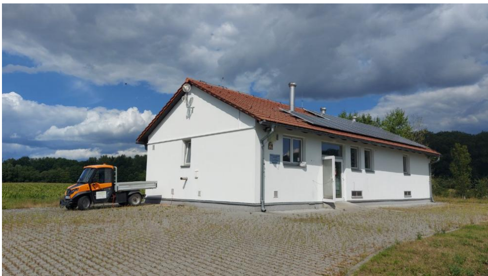
Obrázek 23: Čistírna odpadních vod s elektroautem 24
