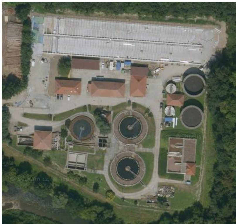
Obrázek 12: Čistírna odpadních vod Litovel 13
