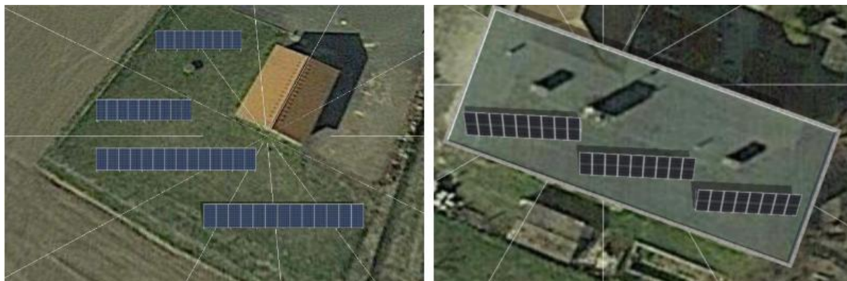
Obrázek 30: FVE u čistírny odpadních vod a na budově školy 32
